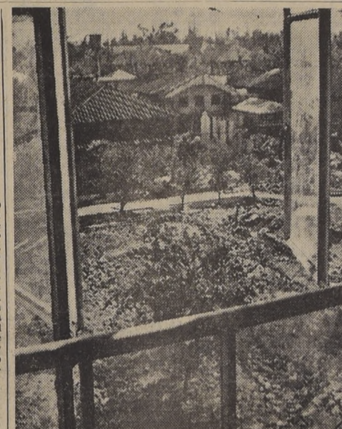
LA OBRA EN MARCHA. — Desde las galerías del nuevo Hospital "José Joaquín Aguirre", se dominan los jibados techos de tejas y los vetustos paredones de lo que fuera el Hospital "San Vicente". Por los cuatro costados de los desmantelados pabellones ha comenzado la demolición para dar paso a la moderna concepción de una Escuela de Medicina de la que Chile podrá vanagloriarse a justo título. Pero no se crea que el nuevo establecimiento va a eliminar la limitación de la matrícula para los postulantés a médicos. No. El Decano nos dijo al respecto que la limitación se mantendrá en los mismos 140 alumnos que actualmente ingresan cada año. No es cuestión de capacidad —añadió— sino de la necesidad de que los profesores mantengan un control estrecho y directo sobre los alumnos.
