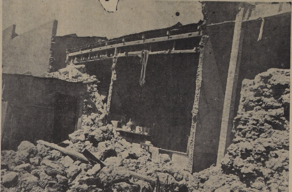
DANOS CONSIDERABLES EN CALAMA. — El violento temblor de la noche del día 6 de diciembre, no sólo destruyó totalmente las de concreto, como el que nos muestra el grabado. Una de las piezas interiores, correspondientes al Club Calama, muestra los efectos del sismo que obligará a la total reconstrucción de esta ciudad, según anunció el Ministro de Obras Públicas, don Orlando Latorre, después de la visita de esta zona devastada. En una mesa, en el interior de uno de los reservados del Club Calama, aún pueden verse una damajuana y jarros, que los cuatro jarros en que bebían sedientos milleros a quienes sorprendió el temblor en plena y abundante libación. Damajuana y jarros, que- daron a la espera de sus escarmentados devotos.
