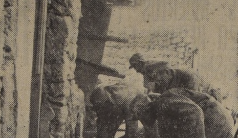
DEMOLICION DE EDIFICIOS EN CALAMA
