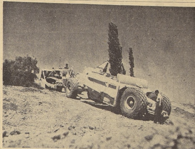
450 HECTAREAS RECIBIRAN MEJOR RIEGO. — En la zona de Bulnes, parte integrante del área del Plan Nuble, se construye un tranque para almacenamiento nocturno de 15 mil metros cúbicos de agua, con los cuales se mejorará el riego de 450 hectáreas agrícolas. Cada cinco minutos se remueven 10 metros cúbicos de tierra por este tractor D-7, con su maciza tralla.
