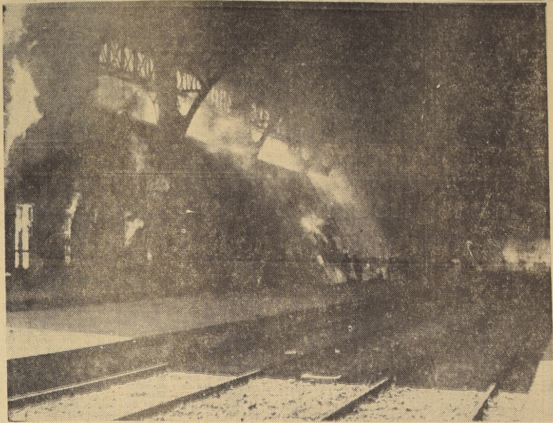
PARTE DE LA ESTACION ALAMEDA ARDIO DURANTE DOS HORAS, AYER.—
