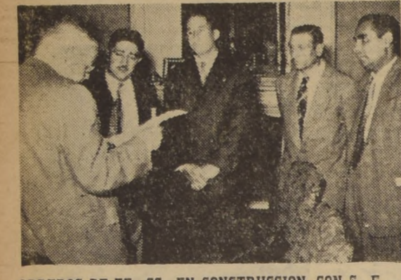
OBREROS DE FF. CC. EN CONSTRUCCION, CON S. E. —
