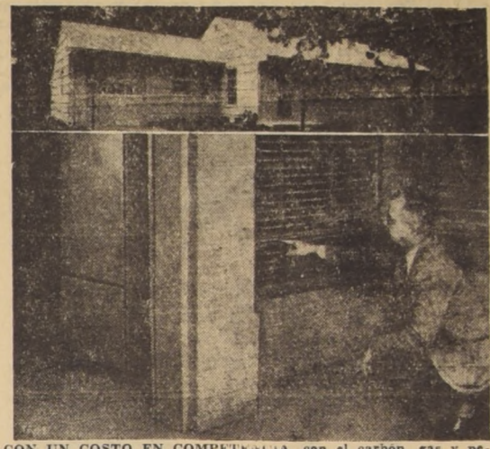
CON UN COSTO EN COMPETENCIA con el carbón, gas y petróleo, una nueva máquina eléctrica acciona como la heladera eléctrica y produce aire acondicionado para todo el año, más una calefacción para todo el hogar. El grabado nos muestra una casa rural, en la que se ha instalado una bomba sistema "aire rural" que expulsa el aire caliente en verano, y convierte el aire frío exterior en aire caliente interior, durante el invierno. En la parte inferior del gráfico, vemos a un experto en aire acondicionado señalando la toma de aire exterior disimulada en la persiana. Detrás, a la izquierda, puede verse la caja que contiene la bomba calorífica.
