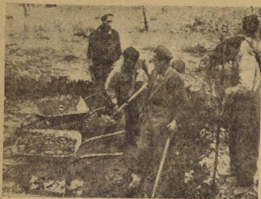
MEJORAMIENTO DE CAMINOS.—(COPIAPO).—Un acelerado ritmo a la construcción de caminos en la zona norte está imprimiendo el Ministerio de Obras Públicas, conjuntamente con las obras de progreso urbano que realiza la Municipalidad. Con motoniveladoras y con palas y barretas se están preparando los caminos para su pavimentación. Un grupo de obreros aparece en el grabado en plena labor.
