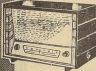
Modelo 5-Q-25. 5 tubos. Onda larga y corta. Conexión para discorola.
