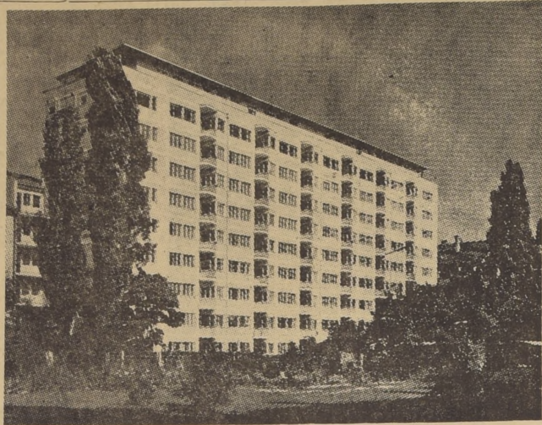
EDIFICIO DE DEPARTAMENTOS. — (Arquitectos: Ernest M. Lang y Martin Eisesser, Münden, Alemania). — Podemos apreciar en el grabado la hermosa estructura de un moderno edificio de departamentos, en Münden, Alemania. El bloque de la construcción es de nueve pisos, contiene 82 departamentos y 3 locales comerciales. Cada departamento tiene en su terraza una cocina para lavar, despensa y pieza para
