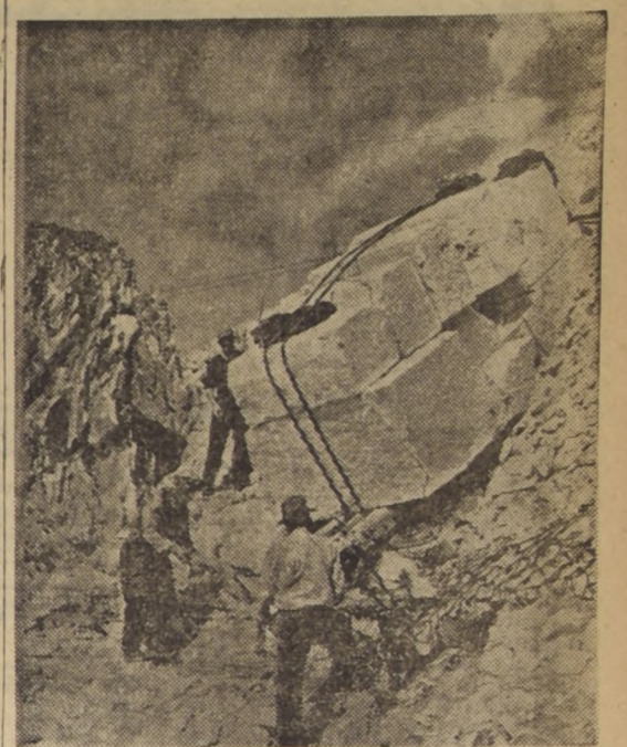
CANTERA DE MARMOL. — A través de los tiempos el mármol de Carrara ha sido el más preciado por los escultores para la realización de sus inspirados sueños, y para los arquitectos, ávidos de colocar en sus construcciones el producto de esta especie más famosa en el mundo entero. Grandes bloques, extraídos con enormes sacrificios y dificultades, son ascendidos, luego, como muestra el grabado, hasta la cima de la cantera, donde se embarcan con destino a todo el orbe.
