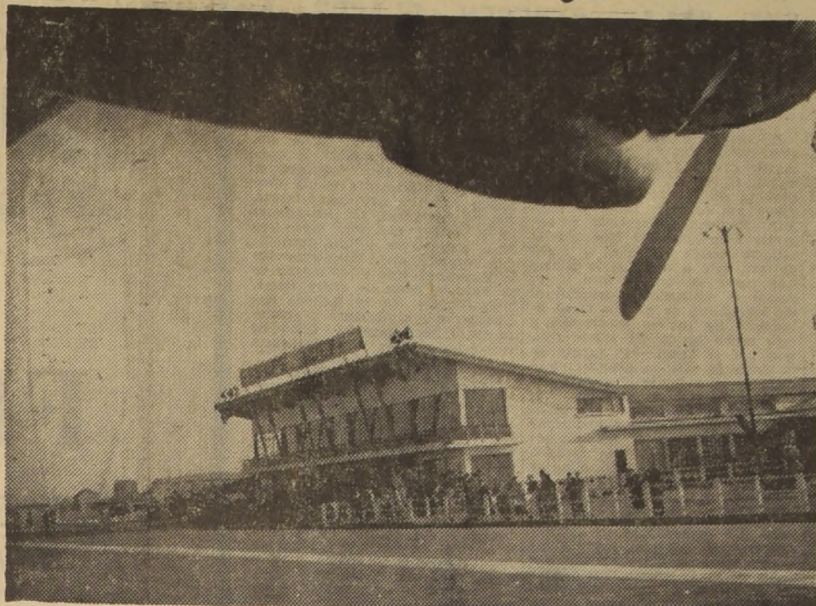
EL PARQUE DE LA GIRA — Este moderno aeropuerto, que forma parte de París, ocupa en una meseta situada nueve kilómetros al sur de la Puerta de Italia, una superficie de 775 hectáreas. Actualmente posee tres pistas de cemento de 60 metros de ancho. La más larga, de dos mil veinte metros, puede recibir aviones hasta de ciento treinta y cinco toneladas.
