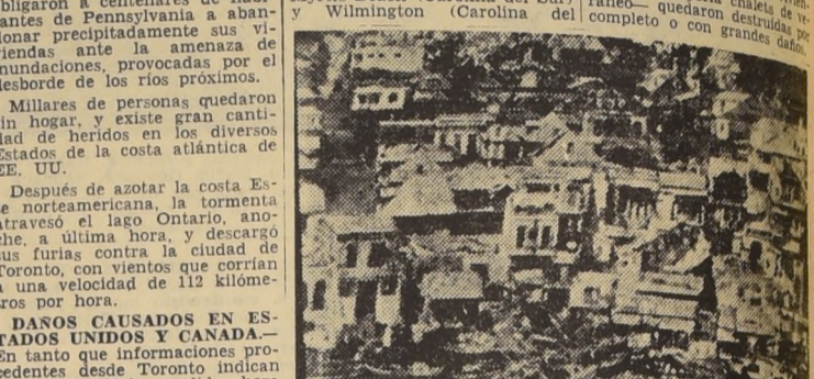
Jeremie (Haiti). Vista aérea que muestra los hoteles, las casas y las viviendas destruidas por el huracán "Hazel", delando en la zona una huella de muerte y destrucción. (UNITED PRESS RADIOFOTO).
