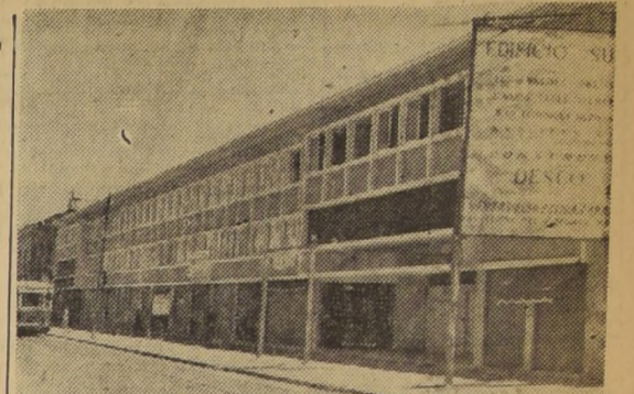
EDIFICIO SAN DIEGO SUR.— Este edificio que construye Desco está ubicado en calle San Diego 933 al 969. Arquitectos, señores Eduardo Valdés, Ignacio Tagle Valdés y Juan Echenique Guzmán. Intervinieron en la construcción las siguientes firmas: Vidrios Dell'Orto, electricidad Arrau y Corti, sanitarios Gerardo Silva, pisos Flexit, Juan Antonio González, estucos Cristián Casanova y ferreteria Ferreteria Santiago.
