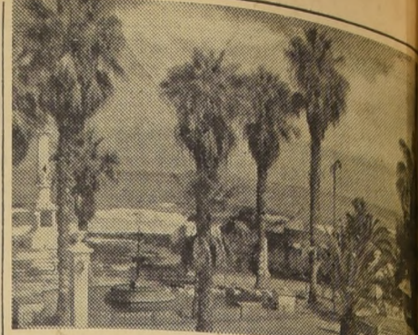
Avenida Balmaceda, de Iquique, en su primer tramo del Canal a Cavancha.
