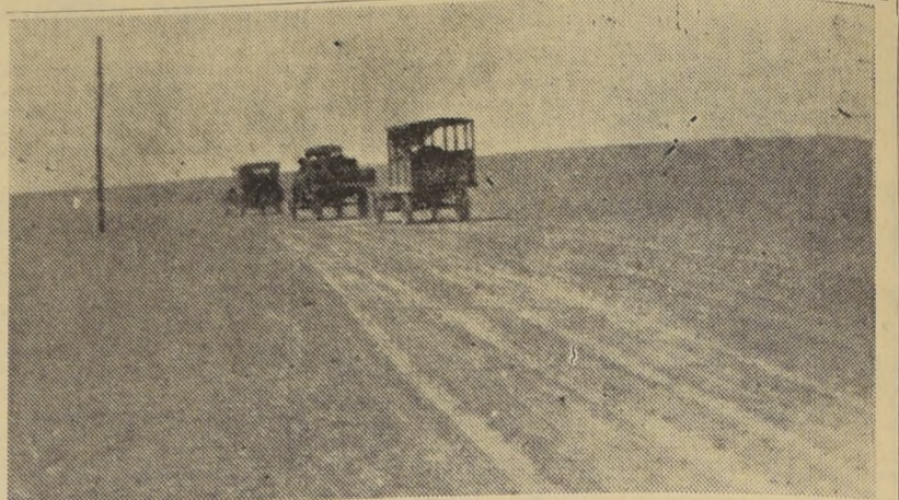
CAMINO DE ARICA A PORTEZUELO DE CHAPIQUINA. — Se encuentra en ejecución el nuevo camino de Arica a Portezuelo de Chapiquina, el cual permitirá expandir notablemente el comercio de esta región. En el grabado aparece una parte del antiguo sendero, antes que el progreso se hiciera presente aún.
