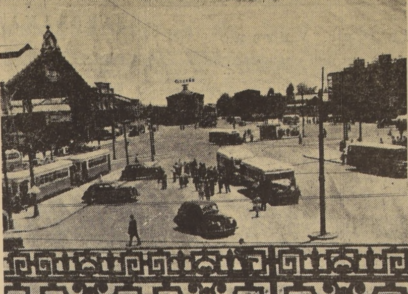
TRANSFORMACION DE PLAZA ARGENTINA. Este importante sector del barrio Estación Central será transformado totalmente gracias a las diligentes gestiones de la Alcaldesa de Santiago, señorita Del Canto, quien logró finiquitar con la Empresa de Ferrocarriles la expropiación de un predio que permitirá ejecutar los trabajos de hermoseamiento de la Plaza Argentina. Los terrenos de la zona serán desamortizados de ese sector y serán ubicados en Los Muermos, a una cuadra de la Avenida General Velásquez.
