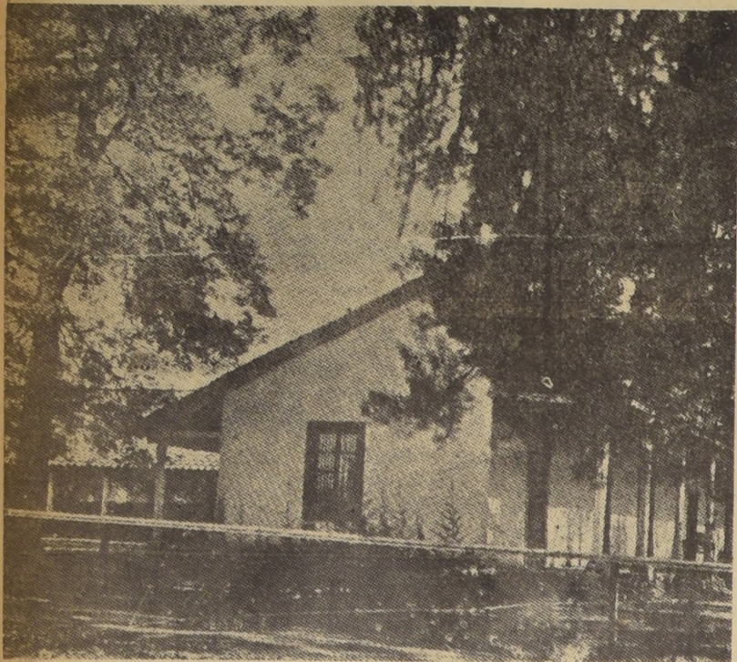
CASAS DEL ACANTONAMIENTO EN EL POLIGONO "GENERAL BARI"
