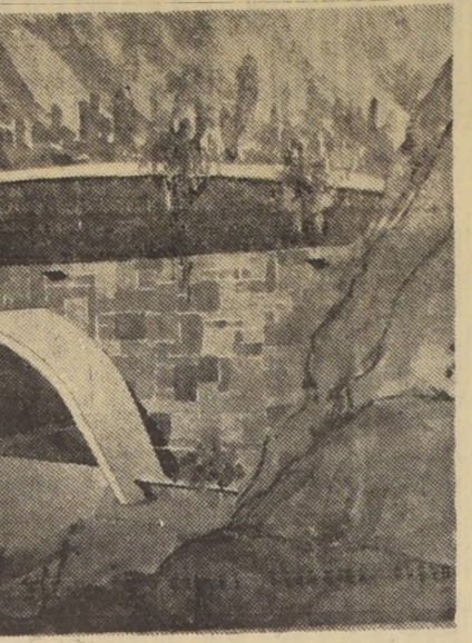
UNA DE LAS OBRAS REALIZADAS. — El Túnel de la Cuesta de Zapata...
