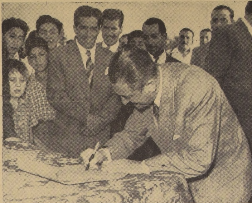
El Vicepresidente de la Corvi, don Orlando Latorre, colocó ayer la primera piedra de la primera Escuela Pública de la Unidad Vecinal que se construirá en la Comuna de San Miguel. Esta primera escuela está situada en la Población Presidente Alessandri, o sea, Población FAMAE. En el grabado vemos al señor Orlando Latorre, firmando el pergamino en el cual se deja constancia solemne del acto.
