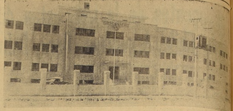
Aspecto del edificio de la Maestranza a que la LAN mantiene en Los Cerrillos
