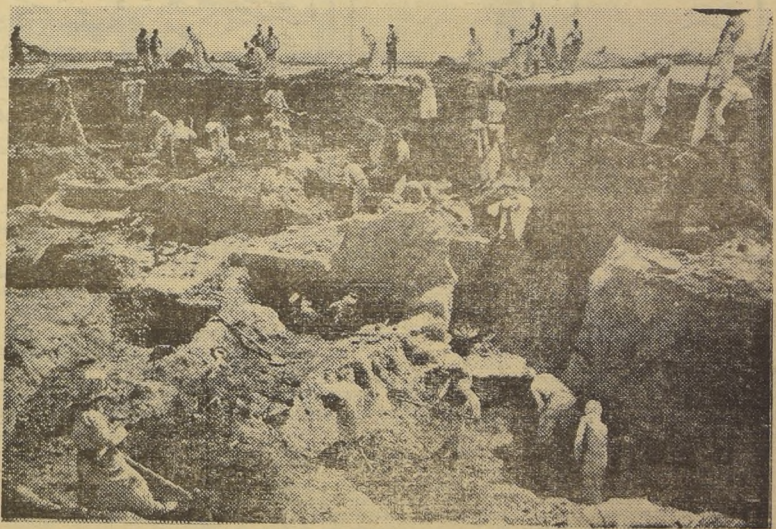
Escena de excavación
