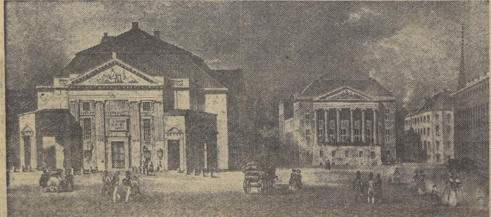
Nota: este edificio fue construido como el del Teatro Real, de Copenhague. Allí dirigió sus primeros pasos cuando, a la edad de 14 años, llegó a la capital danesa como aspirante a actor, más tarde como autor dramático.
