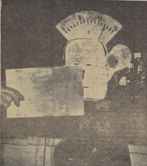
El desplazamiento de la aguja (parte superior del grabado) demuestra que este autómata ciego "siente" la aproximación de un cuerpo. En este caso, una hoja de cartón.
