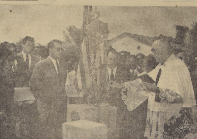
En la mañana de ayer, en el vecino pueblo de Maipú, se efectuó la ceremonia de colocación de la primera piedra de la Escuela Primaria que construirá INSA para educar a los hijos de sus obreros y en la que, además, funcionará una Escuela Nocturna para Adultos. En el grabado, al Capellán de la FACH, señor Francisco Ramírez, en el momento que bendice la primera piedra ante el Subsecretario de Educación, señor René del Villar, autoridades y personal de la INSA.
