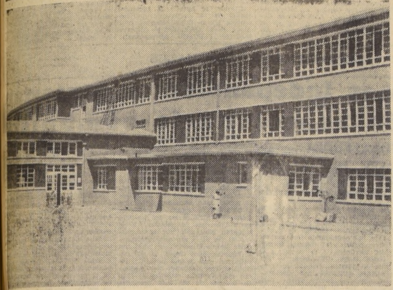
Detalle interior del establecimiento, donde se observan los amplios ventanales de las salas de clase y otras dependencias, que dan suficiente claridad a los interiores, logrando con esto un ambiente agradable y acogedor
