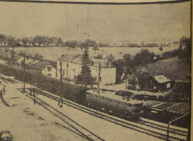
Vista del tren teleguiado, que por primera vez en la historia corrió conducido a distancia, el 13 de abril del presente año, en la línea de Mans. La máquina eléctrica es gemela de la que recientemente batió el record mundial de velocidad, y en su parte superior se distingue la antena de telemando. Aquí se ve al convoy al pasar por la estación de Sceaux-Beisse. (Foto Intercontinental).
