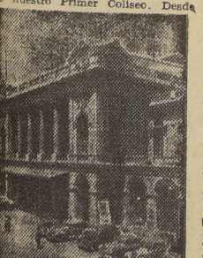
FACHADA del Teatro Municipal.
