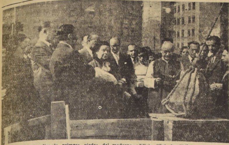
Monseñor Vives bendice la primera piedra del moderno edificio "Sol de Chile", ubicado entre Teatinos y Amunátegui
