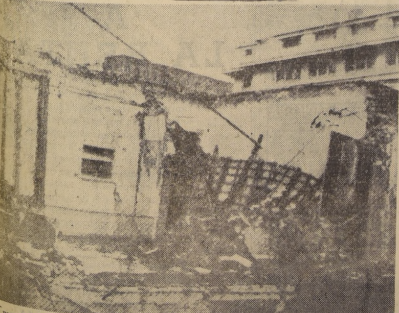
BUENOS AIRES. - La fotografía muestra el estado en que dejó al patio central de la Casa de Gobierno una de las bombas arrojadas por aviones navales durante el estallido revolucionario de la semana pasada. (Radiofoto de la UNIDAD PRESS).
