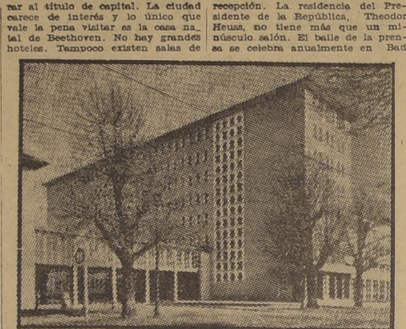
CAJA DE CAUDALES DE BONN.— En este edificio, de sobrias líneas, funciona el Ministerio Federal de Hacienda del Gobierno de Bonn.
