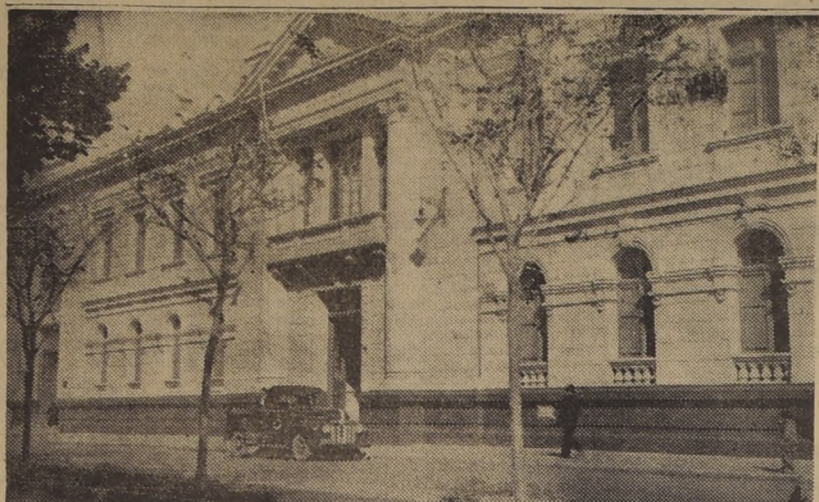
El edificio de la Intendencia de Antofagasta que ayer fue destruido por un violento incendio y cuyas paredes alcanzan a varios metros de peso.
