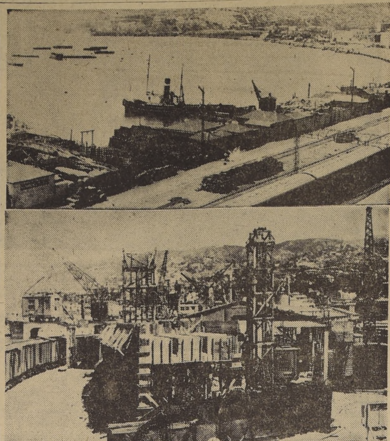
DOS ASPECTOS DEL PUERTO DE VALPARAÍSO en donde se van a efectuar importantes obras de mejoramiento con un costo cercano a los treinta millones de pesos, para dejarlo en mejores condiciones de movilizar la carga que llega y sale por la vía marítima del primer puerto de la República.
