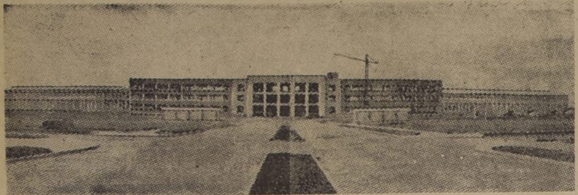
vista de la fachada de la fábrica "Pegaso", en Madrid, donde se construyen los famosos coches sport del mismo nombre, que han sido recibidos con generales elogios por los entendidos de todo el mundo.
