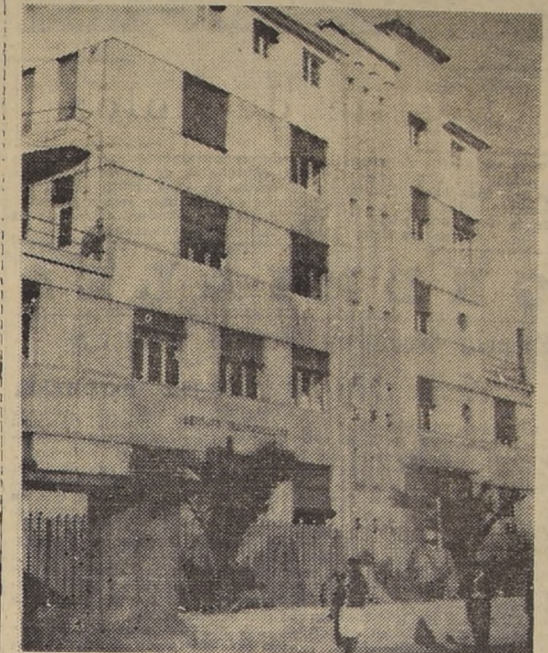
Fachada principal del Instituto Traumatológico de Santiago, cuyos servicios son un verdadero motivo de orgullo para el país.
