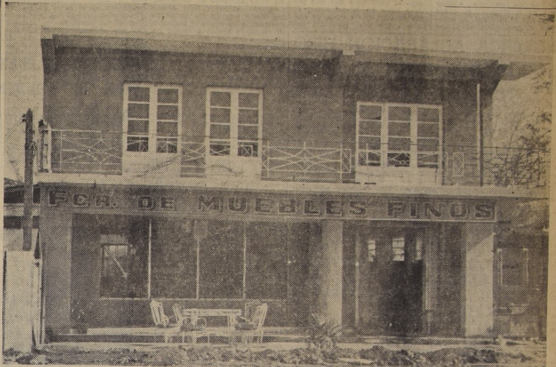
En Santa Elena 2251 se alza el moderno edificio de la Fábrica de Muebles Finos "Kravetz y López", donde las obras más maravillosas del arte mueblístico actual, elaboran experimentados técnicos y personal auxiliar de reconocida competencia.
