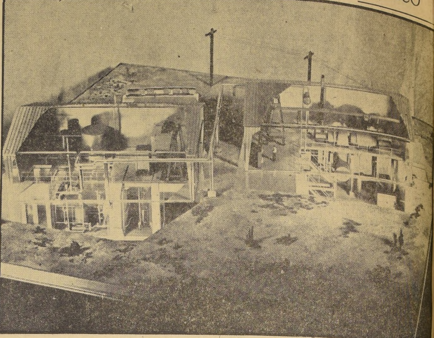
1 VISTA GENERAL de un modelo del Reactor Experimental de Agua Hirviendo del Laboratorio Nacional de Argonne, EE. UU. Este reactor producirá 20 mil kilovatios de calor, que serán utilizados para la generación de 5 mil kilovatios de electricidad. El reactor, el turbo-generador y el resto del equipo están ubicados en la cámara de acero que se ve a la izquierda. En el ala de servicio, a la derecha, se encuentran la sala de control y otros equipos necesarios para la operación. Es el reactor y su equipo asociado deben estar terminados en 1954.
