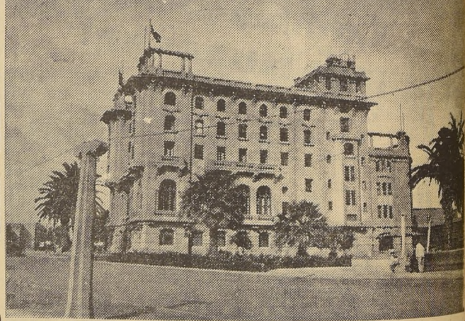
En el grabado vemos al majestuoso Hotel Pacifico, de Arica, cuya estructura ya no está en condiciones de que continúe siendo habitado...
