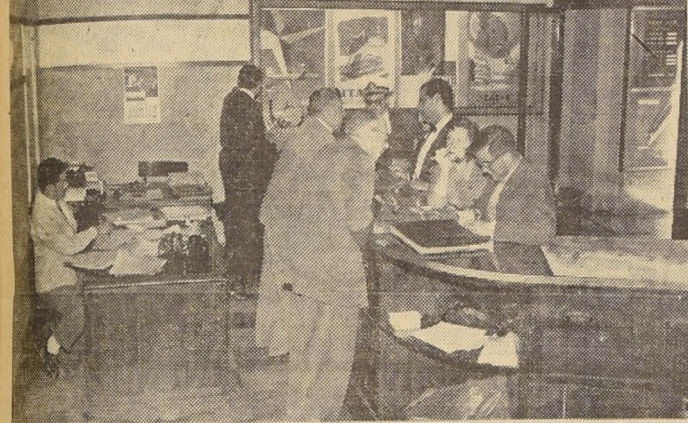
Detalle parcial de las oficinas de "ITALMAR" (Unión Central 1043), Navegación "ITALIA", en Chile.
