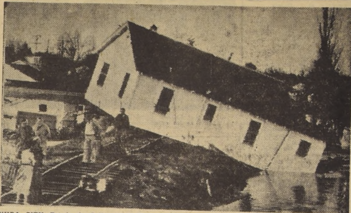
YUBA CITY, Estado de California.— Una casa, arrasada desde sus cimientos por el aluvión, es depositada finalmente sobre el terraplén de una vía férrea. Ayer marcos volvió a presentarse la amenaza de nuevas y más devastadoras inundaciones. Lo cual obligó a unas 10.000 personas a abandonar apresuradamente sus viviendas. (Radiofoto de UNITED PRESS)
