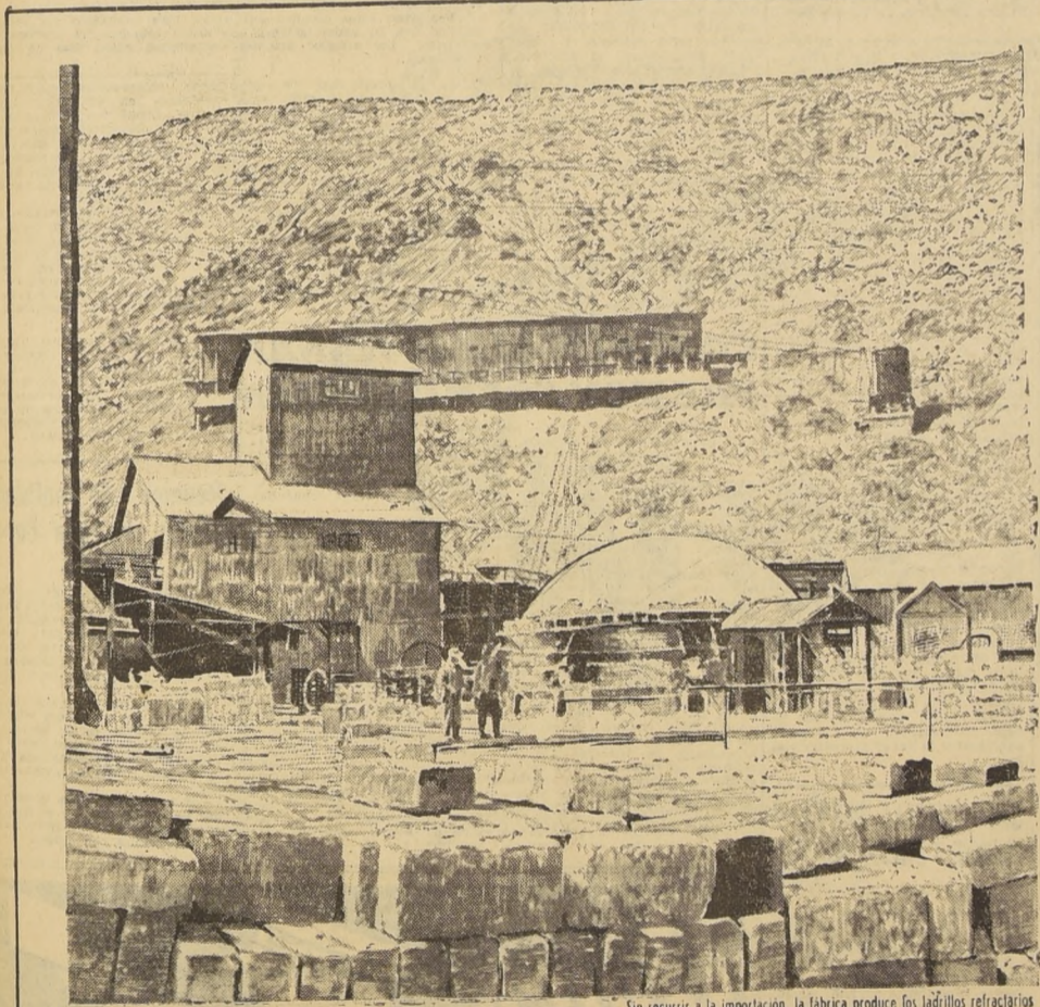
Sin recurrir a la importación, la fábrica produce los ladrillos refractarios
