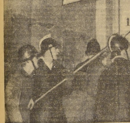
INCENDIO DE NUESTRAS OFICINAS EN ESTADO N.º 63.
