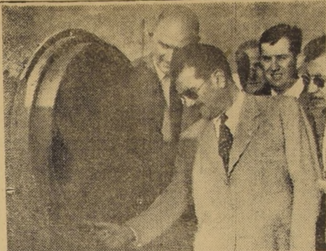
En su viaje a Antofagasta, el Ministro de Obras Públicas, señor Fernández, aprovechó para visitar las maestranzas en donde se están efectuando los revestimientos de los gigantes tubos que se colocarán en el acueducto desde Socome, que dará solución definitiva al problema del agua en esa ciudad. En la foto, el Ministro y su comitiva examinan los trabajos.
