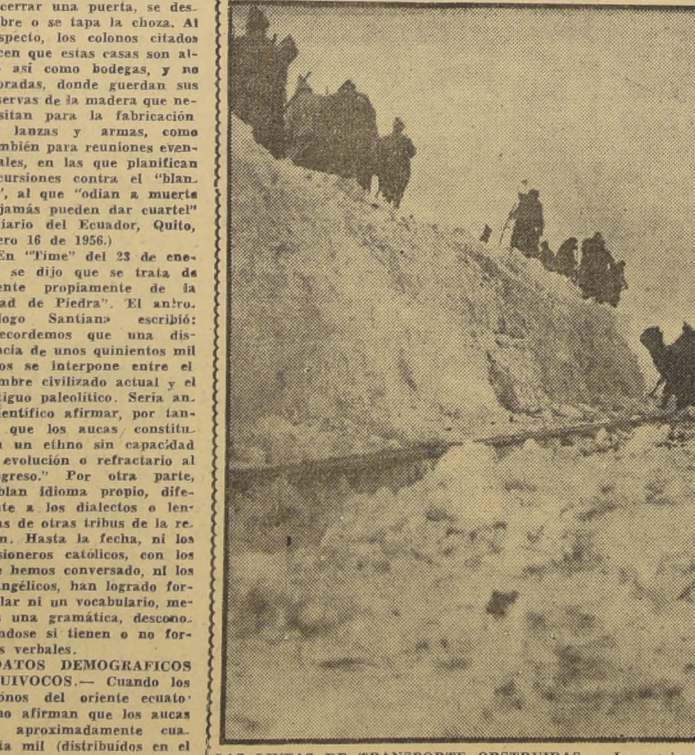
LAS LINEAS DE TRANSPORTE OBSTRUIDAS.— Las recientes nevadas caídas sobre Europa han sido las más violentas y crudas de los últimos 25 años. En la fotografía, se puede ver a un numeroso grupo de trabajadores reparando la vía del tren que parte de París a Bonn. La altura de la nieve puede verse fácilmente. (Foto INTERCONTINENTAL.)
