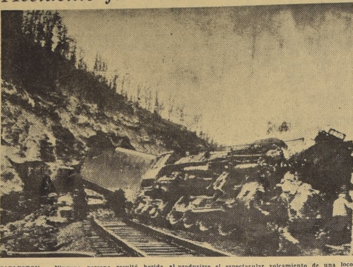
CHARLESTON.— Ninguna persona resultó herida al producirse el espectacular volcamiento de una locomotora y nueve carros de carbón, provocado por un deslizamiento de rocas sobre los rieles.
