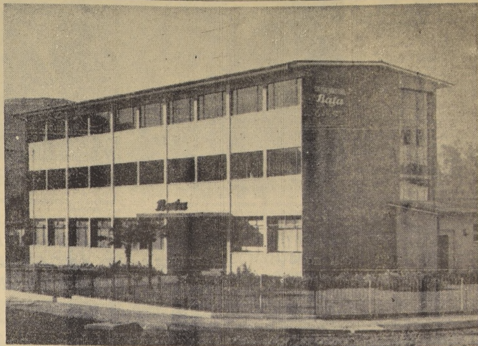
Fachada del Colegio Industrial Bata, construido recientemente. Durante años, el establecimiento funcionó en locales arrendados, pero la importancia que la firma asigna a la preparación de buenos técnicos y buenos operarios, hizo que se levantara edificio propio
