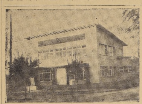
Este es el nuevo edificio que servirá de sede social al Sindicato Industrial de la Compañía Molinos y Fideos Carozzi, en Quilpué. Esta construcción costó a esa institución gremial 14 millones de pesos.
