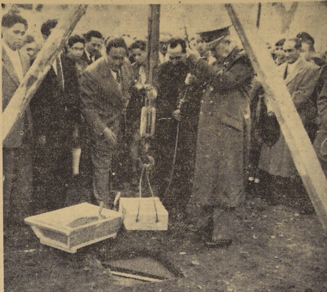
En una solemne ceremonia realizada ayer en Las Condes, el Presidente de la República, Excmo. señor Ibáñez, colocó la primera piedra del edificio destinado al nuevo plantel de la Alianza Francesa, obra que tendrá un costo de 200 millones de pesos y capacidad para mil alumnos. Concurrieron, además, el Ministro de Educación, general don René Vidal Merino; el Subsecretario, don Germán Vidal Duarte; el Embajador de Francia en Chile, señor Jacques Coiffard; el escritor y secretario general de la Alianza Francesa de París, M. Marc Blancpain; el arquitecto francés, señor Jacques Laurent y el presidente de la Alianza Francesa de Chile, señor Pierre René Barre.
