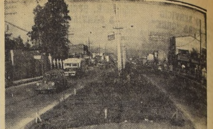
Vista de un tramo de la Gran Avenida en el cual puede verse los bandedones centrales con áreas verdes y algunos arbustos que impiden el encandilamiento de los conductores y vehículos motorizados. Se estima contraproducente, por razones de seguridad, el hecho de quitar dichos arborescentes, que además constituyen un hermoso ornato de esta arteria que comunica la capital con el sur del país.
