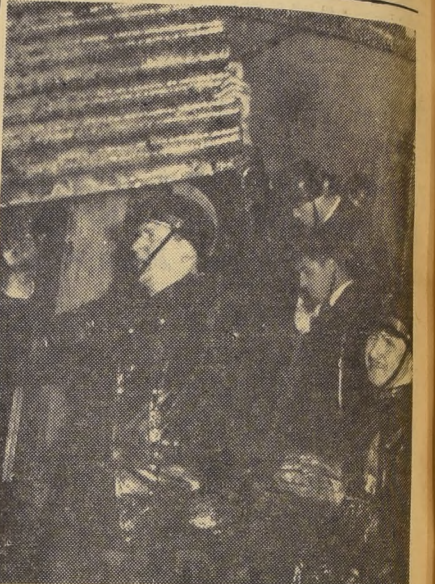
INCENDIO DE HOGAR FEMENINO.—Ardua labor desplegaron en la madrugada de ayer los bomberos para impedir que el incendio que destruyó el hogar de la Agrupación Médica Femenina, en Victoria Subercaseaux N.º 63, se propagara a los edificios colindantes. En el grabado, un bombero recibe una plancha de zinc desprendida del techo. Los detalles del siniestro alcanzaron a ser publicados íntegramente en nuestra edición de ayer.
