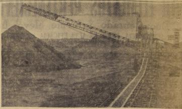
Transportador hacinador de banda Link-Belt automotriz y de radio giratorio de 35 m., con via de 174 m., montado en transportador de banda remolcable acopía en montones de 13 m. de alia mena de hierro lavada en instalación concentradora.
