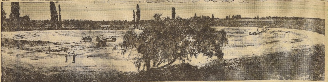
TRANQUE SAN GABRIEL.— Está situado en la zona de Bulnes, y es una clara demostración de los trabajos y obras de regadío que ejecuta el Plan Chillán para aumentar el área cultivable.
