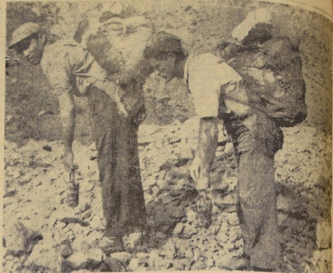
Los capacheros saliendo de la bocamina de un socavón en el Alto Llahuín, con una carga de mineral que sobrepasa los ciento veinte kilos, la cual fue extraída a más de cien metros del interior de la cancha, donde se aprontan a vaciar el contenido. Los capachos son fabricados en cuero de cabra a los que se les somete a un tratamiento especial para darle mayor resistencia. Estos hombres dan treinta vueltas al día y depositan una carga equivalente a tres mil seiscientos kilos de mineral por faena. Portan lámparas a carburo para alumbrarse en el interior de las cavernas, donde reina alta temperatura. Son los llamados "huinchos humanos" de la pequeña minería.
