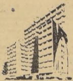
EDIFICIO HUELEN San Isidro esq. Alameda Santiago
